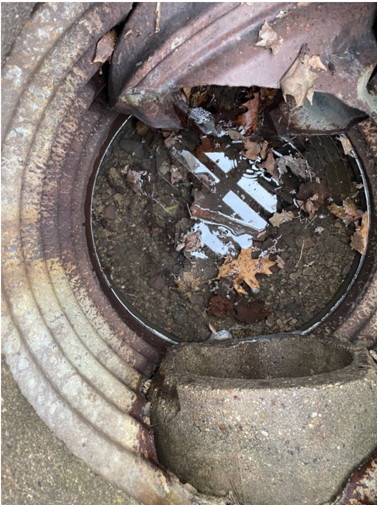
STA 52+85 (RT): EX MH
